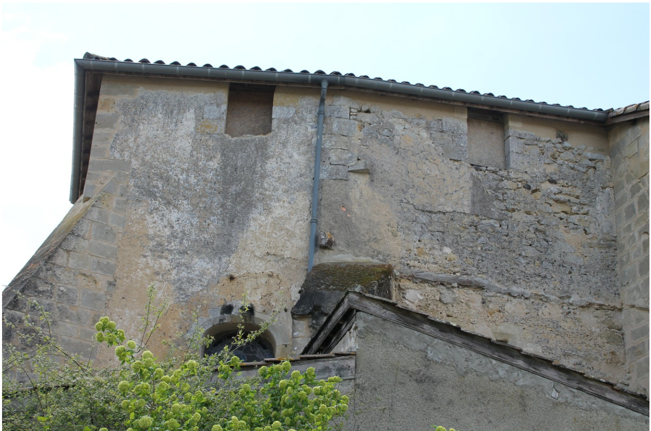
Vues de l'église d'Arboucave. Photo S.A.
