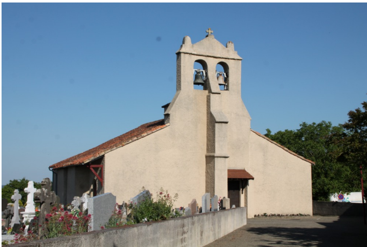
L'église de Philondenx, état actuel. Photo S.A.
