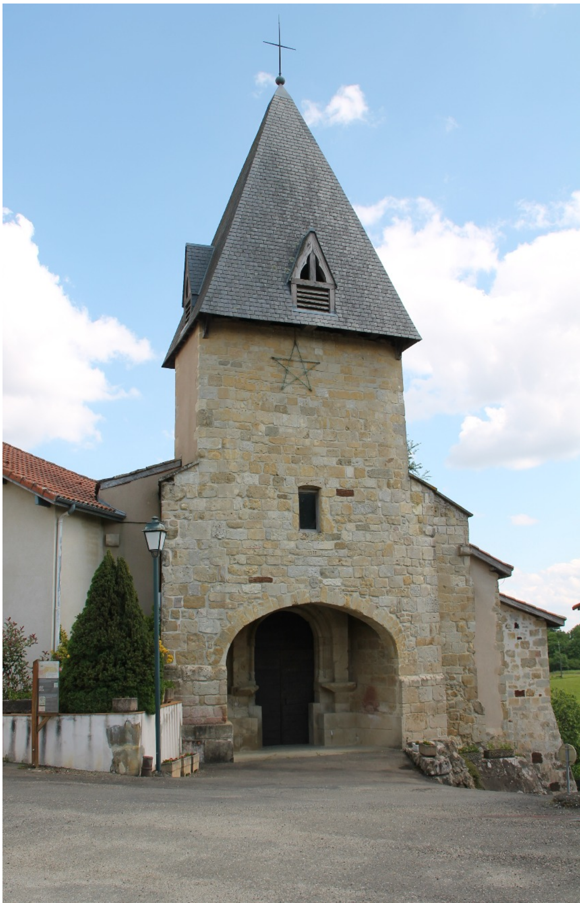
Vue générale du porche de l'église de Castelnau-Tursan. Photo S.A.
