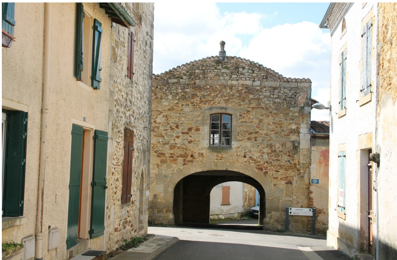
Le pontet, séparation entre le bourg et l'enclos abbatial. Photo S.A.
